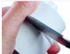
Fig. 7c) Avec un couteau à plâtre, ouvrir au niveau de l'entaille.
